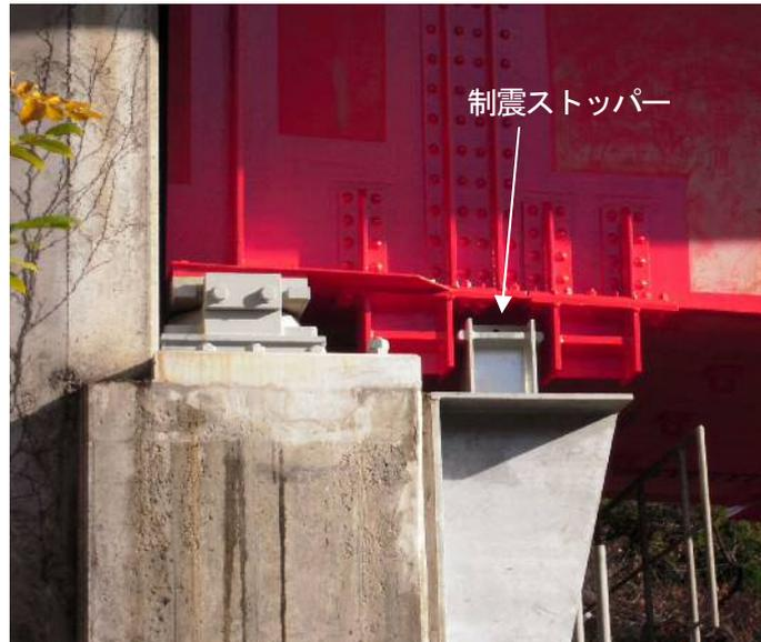
写真-1 橋台前面に設置
