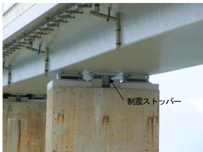
写真-3 PC橋の橋軸直角方向に設置
