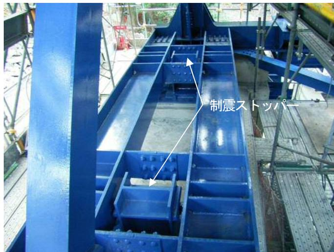
写真-5 トラス橋の橋軸方向に設置
