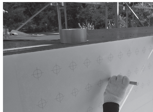
写真-3 実物大フィルムによる野書き(端柱)
