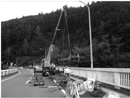
写真-4 部材搬入
