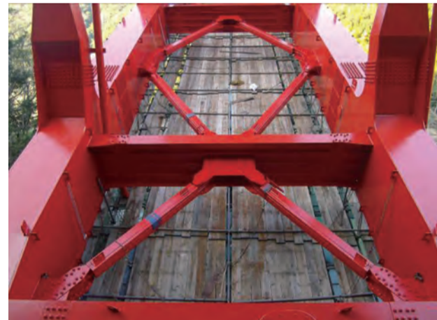
下横構。上はシェイプアップブレースB r 使用前、下は使用后。景観をほとんど変えずに補強している。
