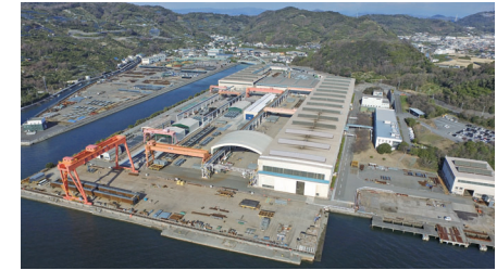
岸壁には100ト吊りクレーンを設置
