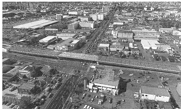
国道4号箱堤高架橋上部工工事
