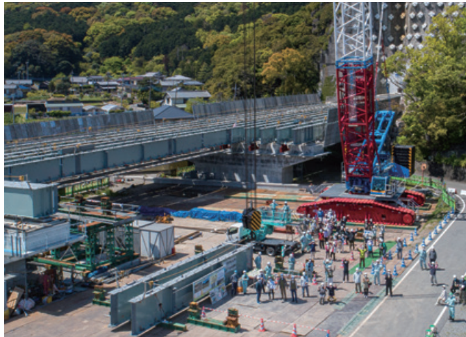
太平高架橋 現場見学会
