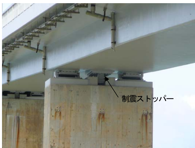
写真-3 PC橋の橋軸直角方向に設置
