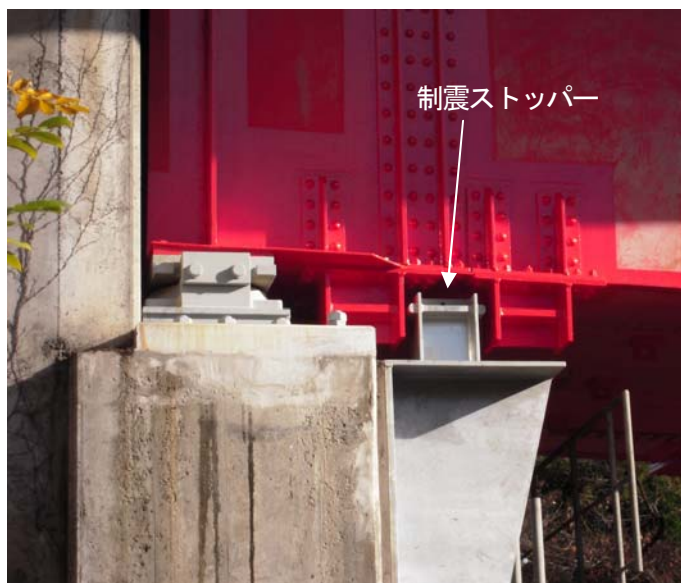
写真-1 橋台前面に設置
