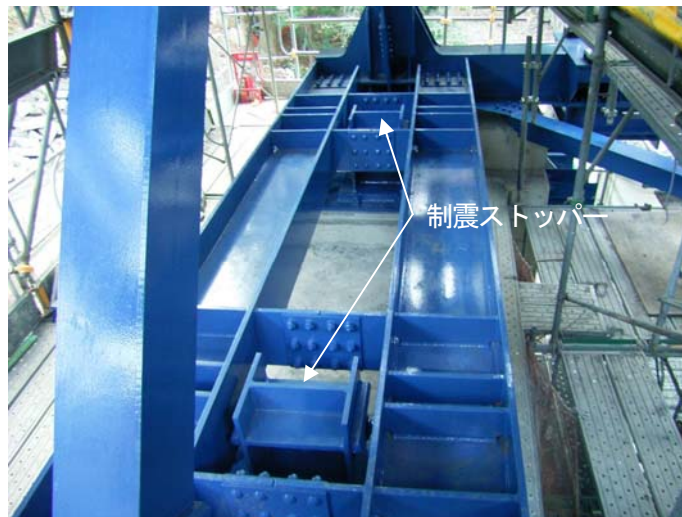
写真-5 トラス橋の橋軸方向に設置
