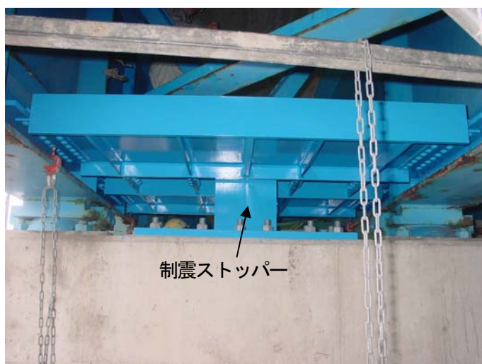
写真-2 鋼桁間に横梁を配置し、制震ストッパーを設置
