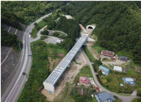
① 令和元年度 力持高架橋上部工工事
