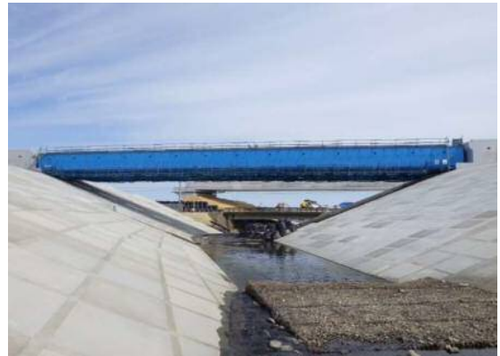
③ 令和元年度 沖ノ田橋上部工工事
