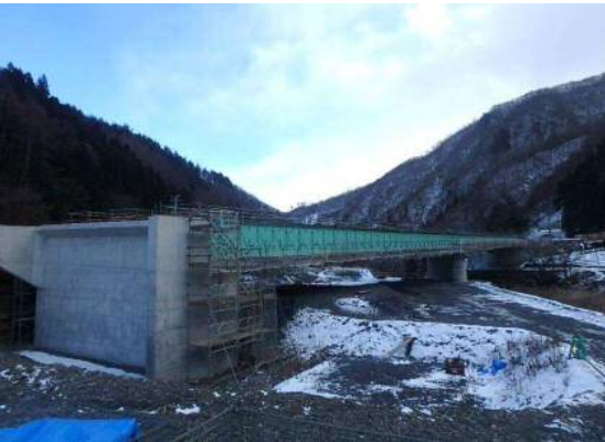
② 令和元年度 国道106号 新箱石大橋上部工工事
