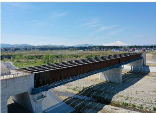
④ 令和2年度 泉田川橋上部工工事
