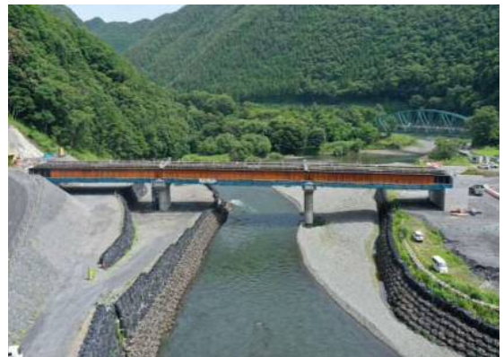
⑤ 令和2年度 下茂市橋上部工工事
