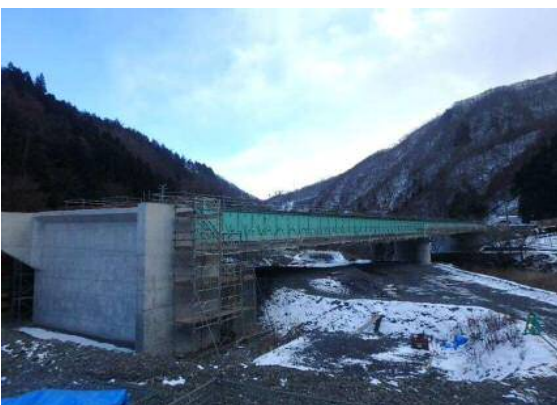
④ 令和元年度 国道106号 新箱石大橋上部工工事
