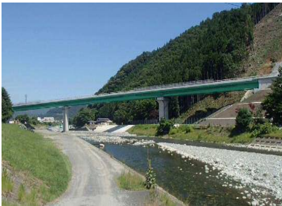
① 平成30年度 国道45号 小佐野南地区橋梁上部工工事
