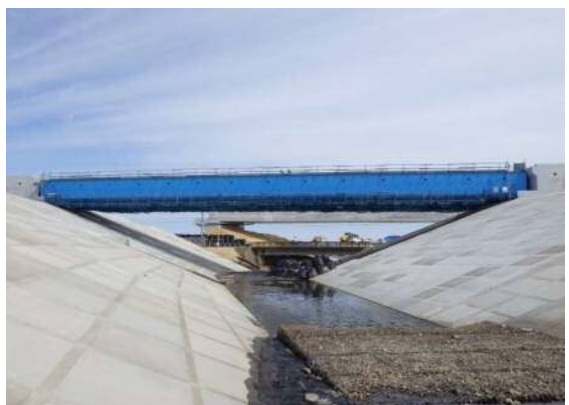
⑤ 令和元年度 沖ノ田橋上部工工事
