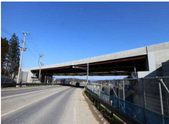
② 平成30年度 平野原橋上部工工事
