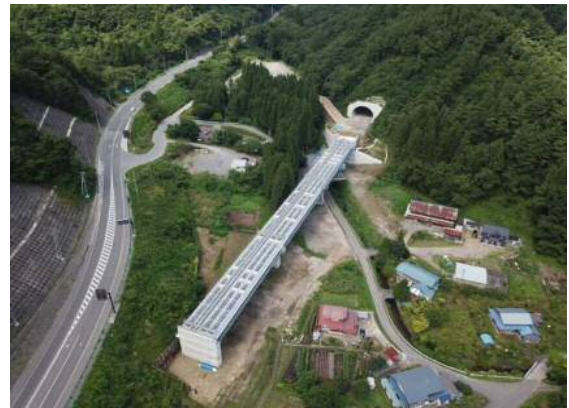
③ 令和元年度 力持高架橋上部工工事
